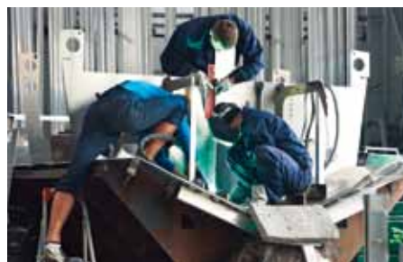
En Anytec 860 SPD byggs upp i svetsfixturen.
